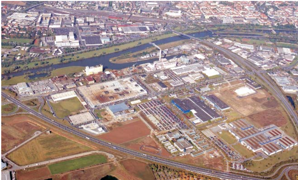
Ein Blick aus der Luft verdeutlicht die industrielle Prägung der Stadt Schweinfurt.
